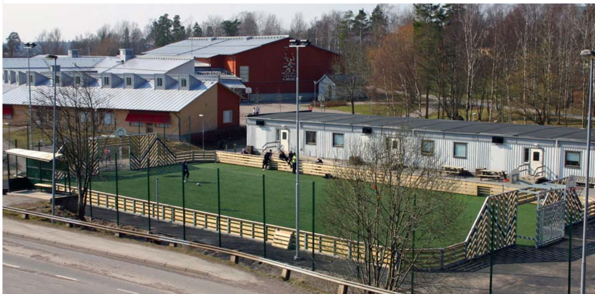
Pärland multisportanläggning vid Skogsängsskolan. Färdigställd 2007.
