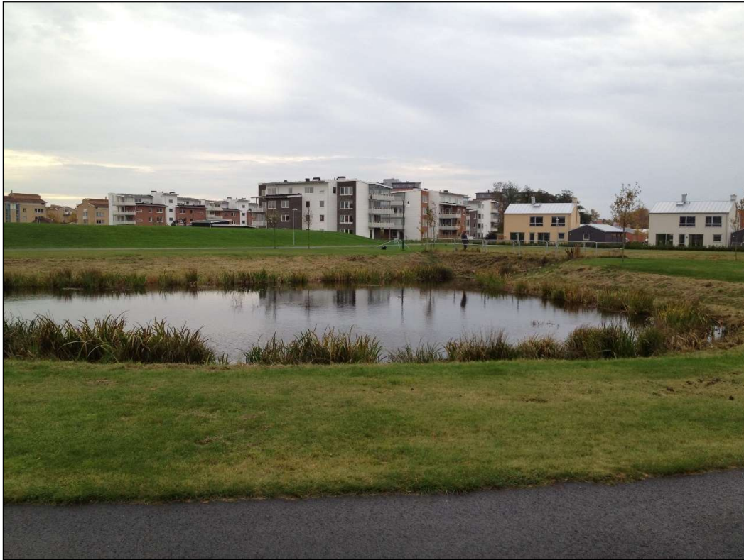
Figur 7. Exempel på dagvattendamm. Foto: Norconsult.
