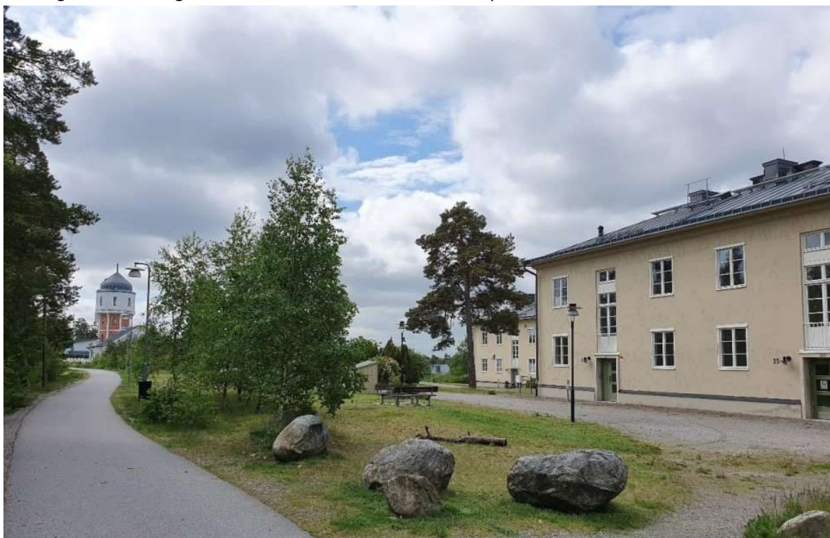
Vy från gång- och cykelväg med patientfamiljshuset samt vattentornet i bakgrunden Foto från antikvariskt konsekvensutlåtande
