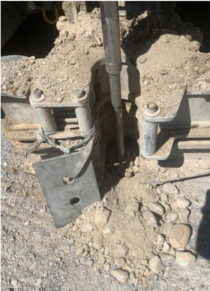
Figur 5. Isälvsmaterial som följt med skruvprovtagaren upp i punkt 22T01 (Foto: Tyréns).
