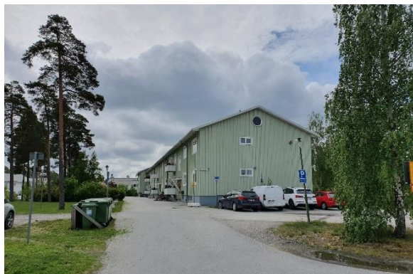
Söder om vattentornet ligger den bevarade f.d. sjuksköterskebyggnaden uppförd på 1940-talet.
