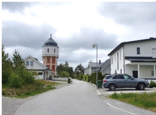
Heterogen villabebyggelse vid vattentornet.
