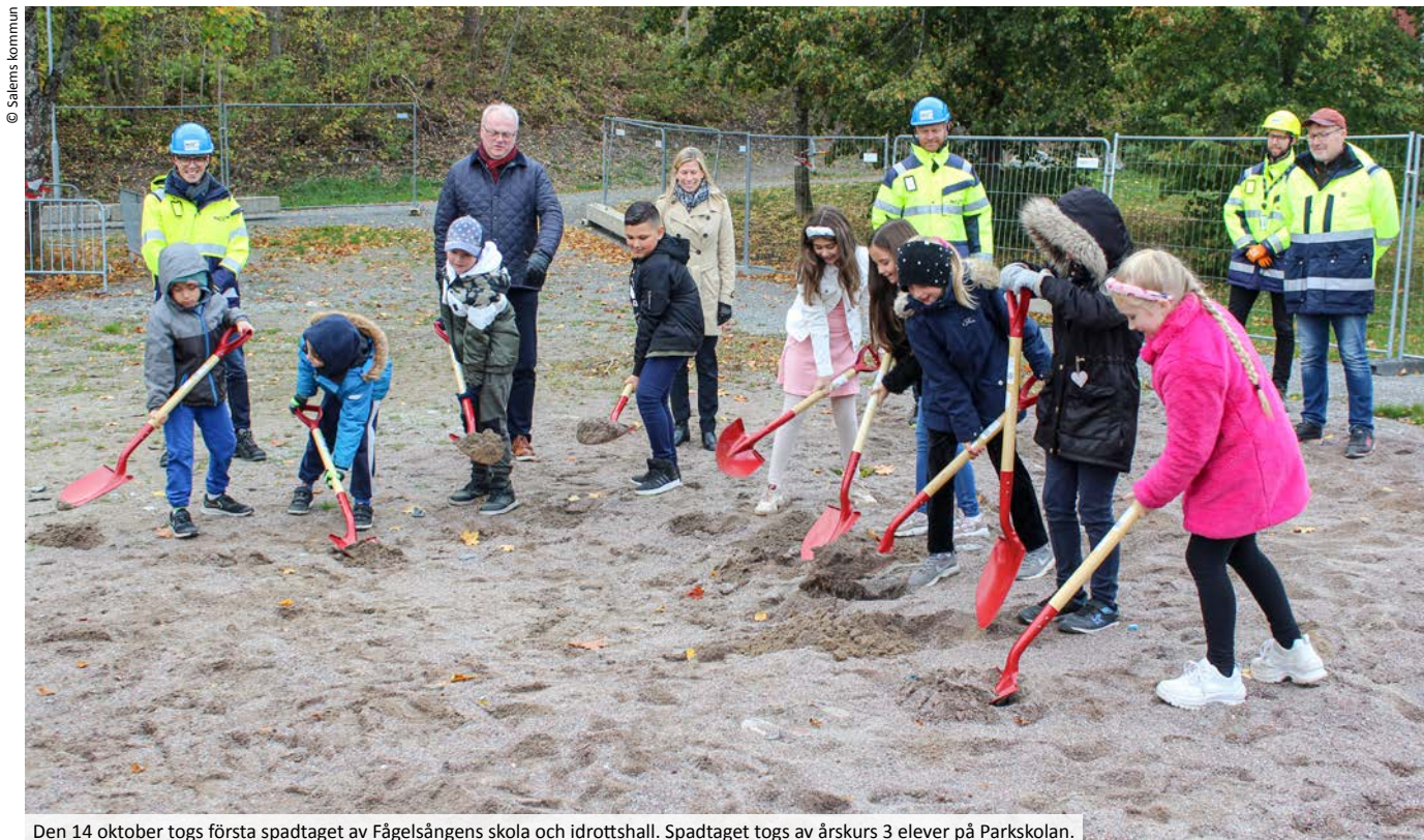
Den 14 oktober togs första spadtaget av Fågelsångens skola och idrottshall. Spadtaget togs av årskurs 3 elever på Parkskolan.
